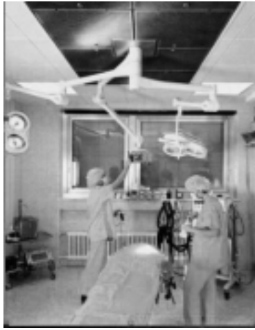
Resim 2. Paslanmaz çelikten direkt laminer akım tavan ünitesi
